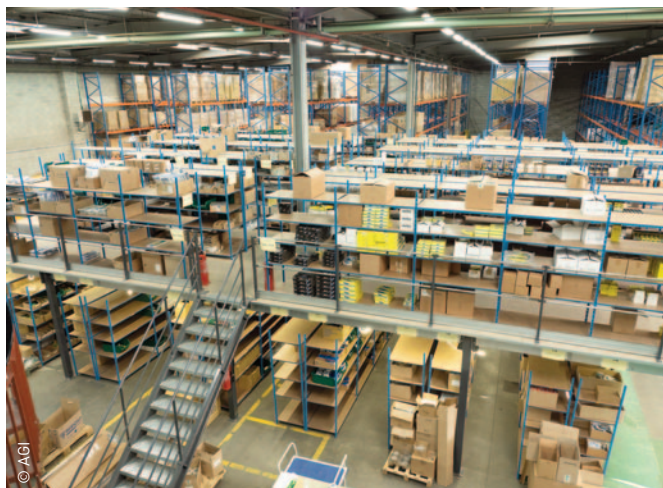
Entrepôt, zone de stockage produits, vue sur mezzanine.
