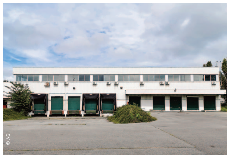
Entrepôt de Saint-Ouen l'Aumône (Val d'Oise).
